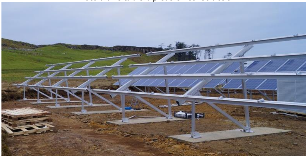
Photo d'une table bipieds en construction
