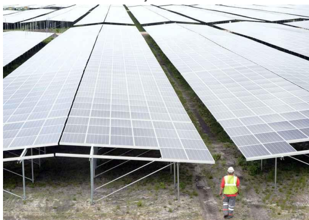
Photo d’une centrale au sol bi-pente est/ouest
