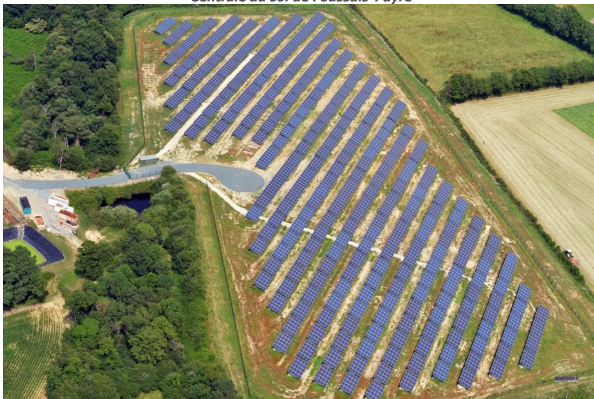
Centrale au sol de Foussais-Payré
