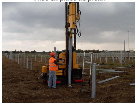
Mise en place de pieux
