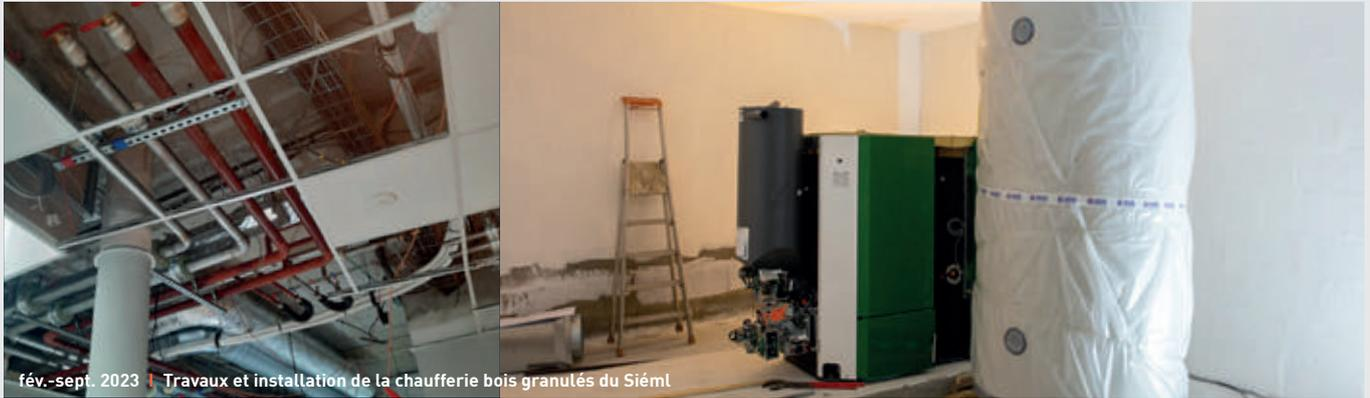
fév.-sept. 2023 | Travaux et installation de la chaufferie bois granulés du Siéml
