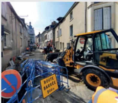
Certains chantiers sont plus ardues que d'autres. Le Siéml a mené à Rochefort-sur-Loire un vaste chantier d'effacement de réseaux d'électricité, d'éclairage et de communications électroniques en milieu urbain dense. Ce projet, visant à réaménager le cœur du bourg, s'est déroulé dans un contexte complexe en raison des rues étroites et du grand nombre d'intervenants impliqués.
