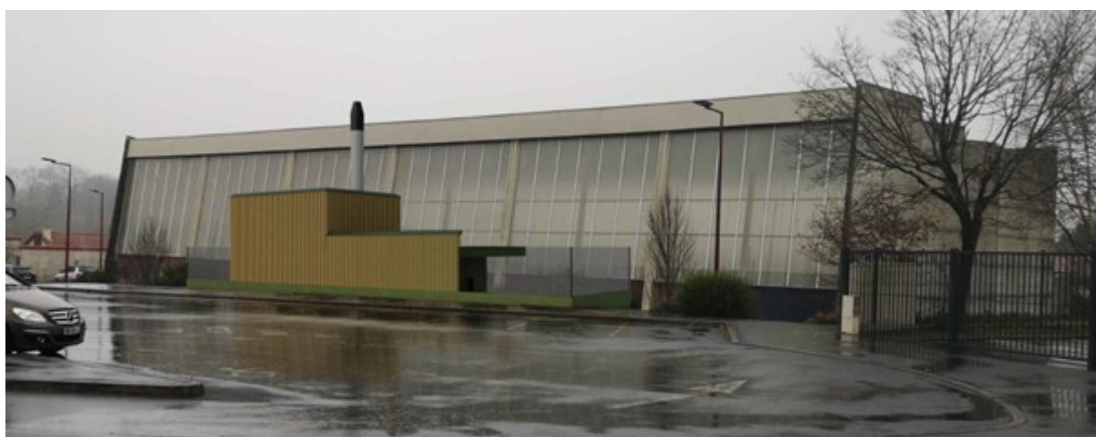
Vue de la future chaufferie
