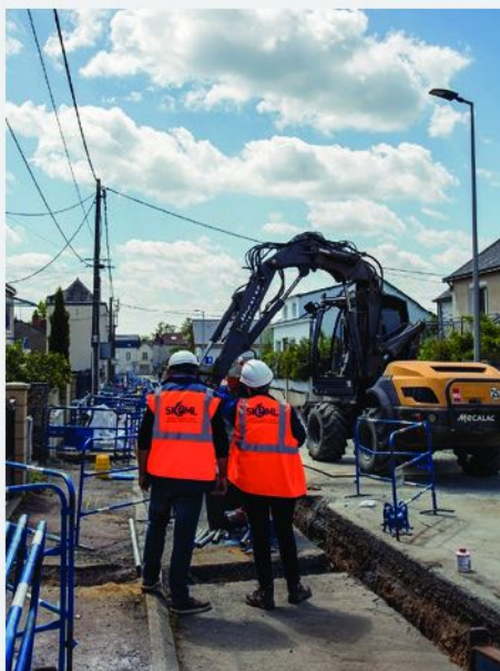
Mai 2025 - Chantier d'enfouissement à Avrillé
