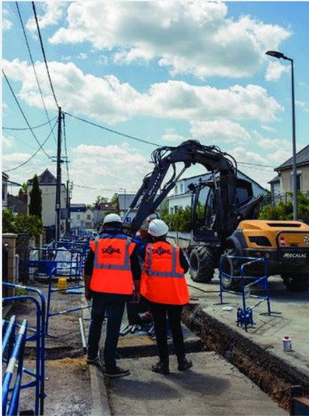
Mai 2025 - Chantier d'enfouissement à Avrillé
