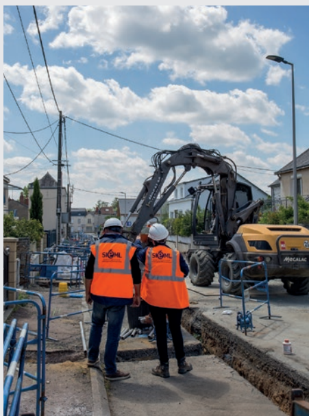
Mai 2025 - Chantier d'enfouissement à Avrillé
